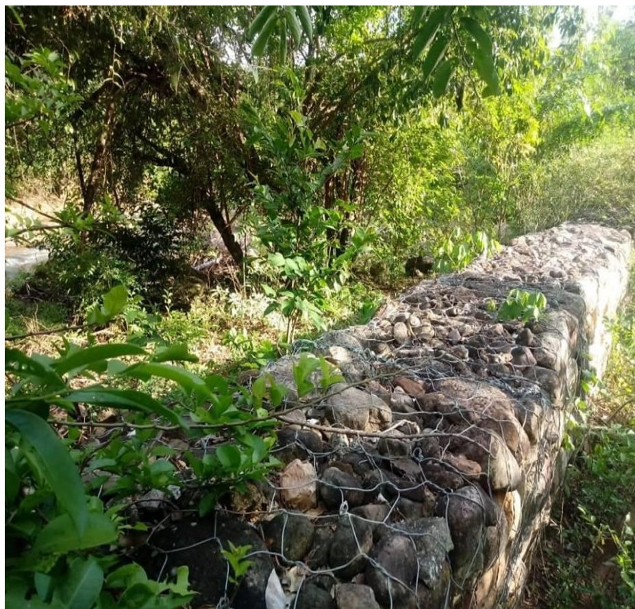
Registro fotográfico de muro de gavión construido en la vereda Vega Grande.
