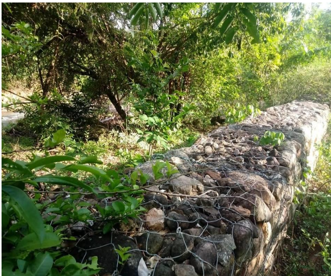
Registro fotográfico de muro de gavión construido en la vereda Vega Grande.
